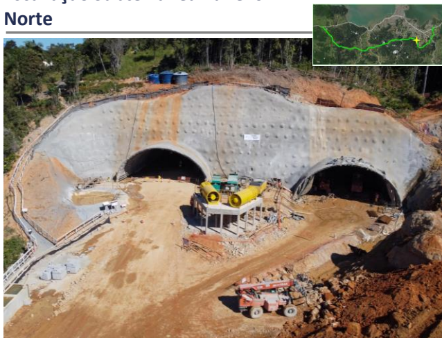
Construção de Embosques- Túnel 02 Sul
