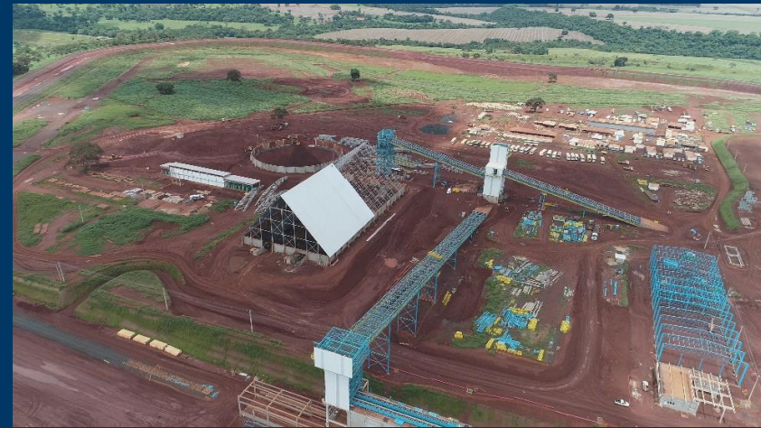
Terminal de Rio Verde (GO) em obras
